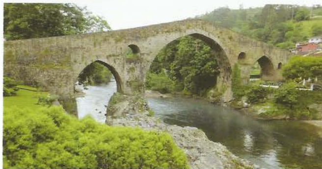
Puente romano de Cangas de Onís.
