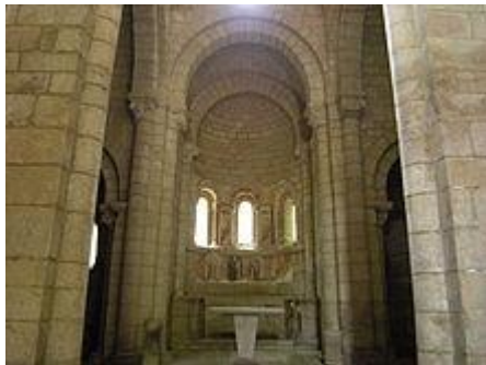
Nave de la iglesia.
